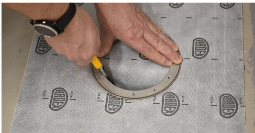
Når mansjetten er montert, skjæres mansjetten ut av sluket. Bruk en skjæremal for å få riktig diameter på hullet.
