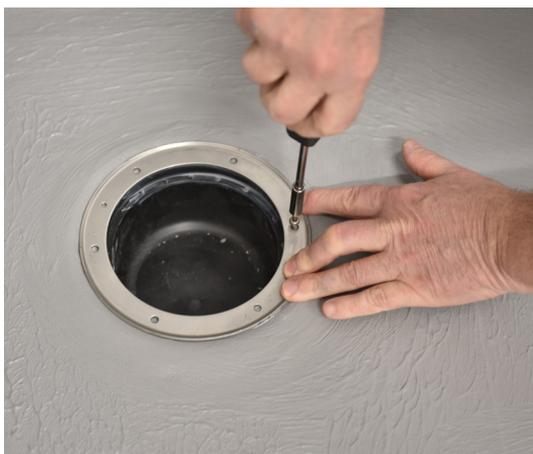
Før klemringen monteres, skal hele mansjetten dekket med to strøk membran - også under klemringen.
