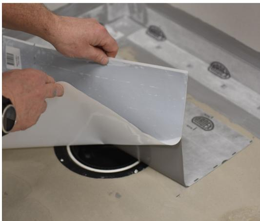
Til tetting rundt sluk brukes en STA 40-40 selvklebende slukmansjett. Slukmansjetten kan monteres direkte på primet underlag, eller den kan monteres i våt membran.
