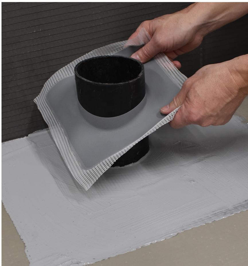
Rørmansjetten monteres i våt membran og presses inn i den våte membranen med en firkantskje e.l., slik at det ikke etterlates luftlommer under rørmansjetten.
